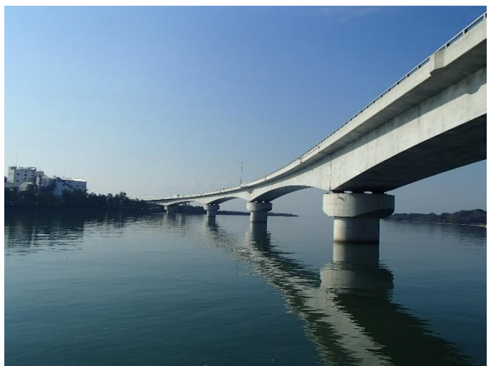
[小野田湾岸道路(有帆川大橋)]
