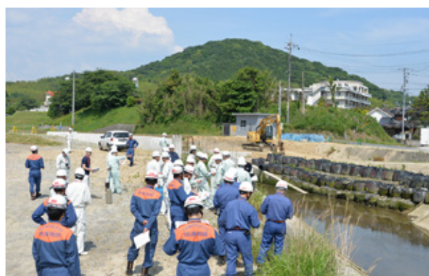
▲防災パトロールの様子(糸根川周防高潮対策事業)
