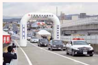
小野田湾岸道路(有帆川大橋)開通
