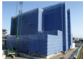
▲新病院建設現場
