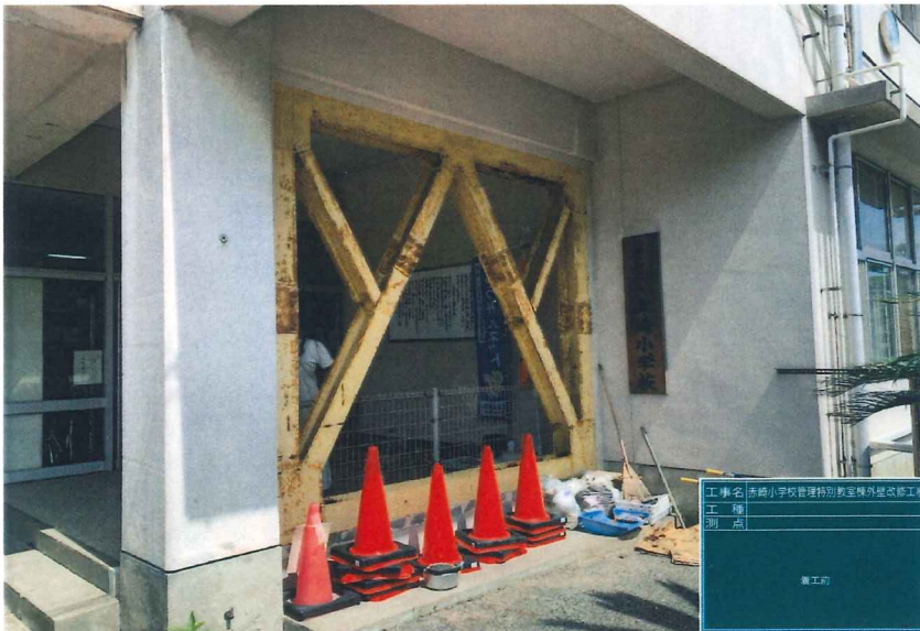
赤崎小学校管理特別教室棟外壁改修工事
