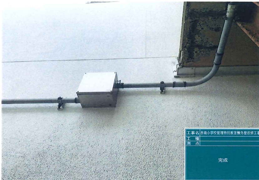
赤崎小学校管理特別教室棟外壁改修工事
