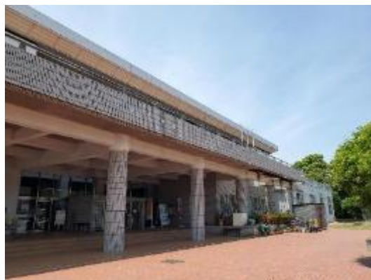
市民体育館整備事業（空調等整備）
