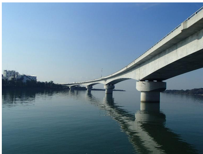
[小野田湾岸道路(有帆川大橋)]
