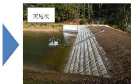
防災重点農業用ため池の改修整備（出典：山口県国土強靱化地域計画）
