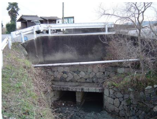
現在も残る二挺唐樋の遊水地側の樋門跡 平成20年（2008）★11
