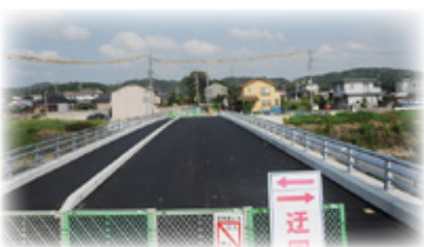
▲工事中の厚狭志んはし
