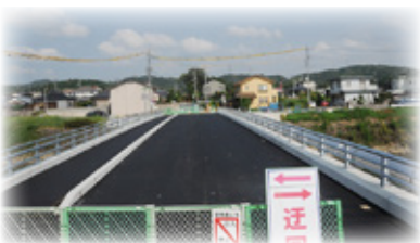
▲工事中の厚狭志んはし
