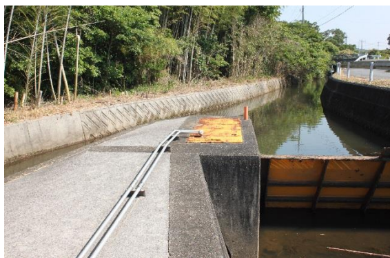
▲現在の茅場分水（下流から）
