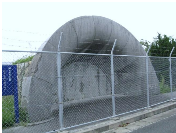
旧本山炭鉱斜坑坑口 平成 22 年（2010）撮影 ★40
