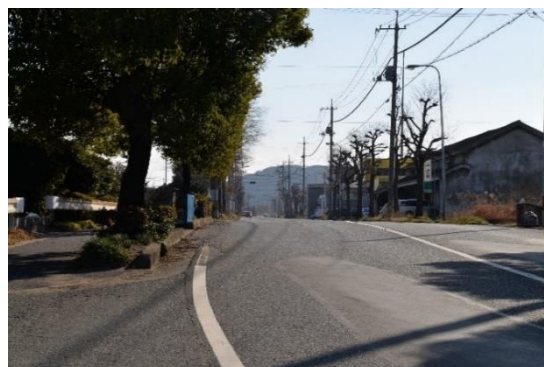
小野田古開作の堤防跡「八丁土手」 現在の港町付近 令和7年(2025)撮影 ★25
