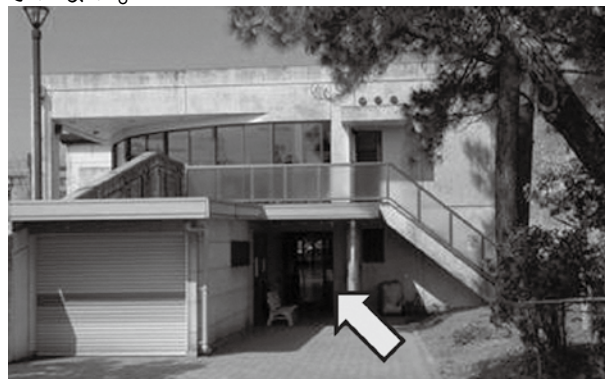
公園内から直接入れるトイレ入口
