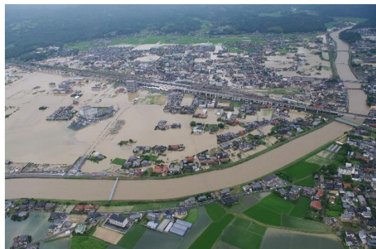
平成 22 年 7 月 12～15 日大雨 (厚狭川洪水)
