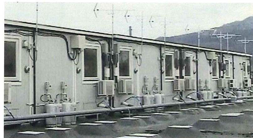
【仮設住宅へのLPガス設置】
