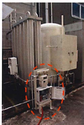
SGU-4を設置したところ
