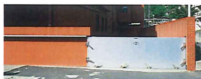
地下駐車場出入口 長崎県成人病センター（長崎県）
