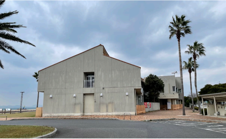
現況南面外観
