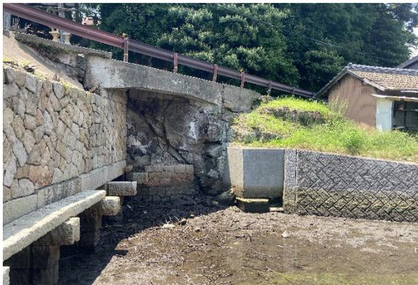
写真 4-18 遊水地側 樋門 (石垣 (右岸)、岩盤 (右岸))
