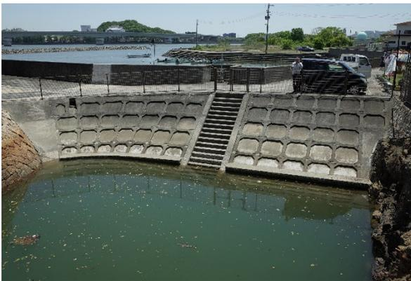
写真4-23 湾側 コンクリート堤体 (階段、暗渠含む)
