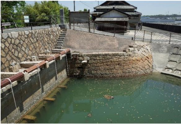
写真 4-3 湾側 樋門 (袖石垣 (左岸)、石階段、法面)
