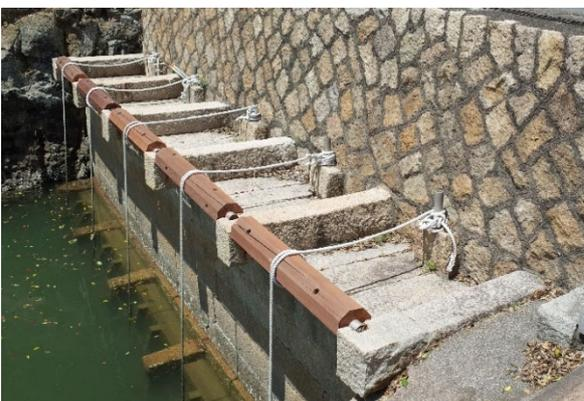
写真 4-9 湾側 樋門 ろくろ、ロープ、ロープ止め
