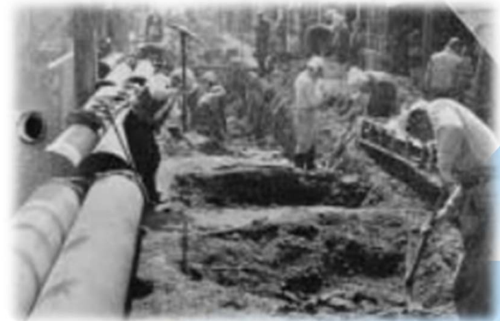
昔の工事の様子
