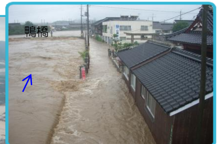
鴨橋周辺の厚狭川氾濫状況
