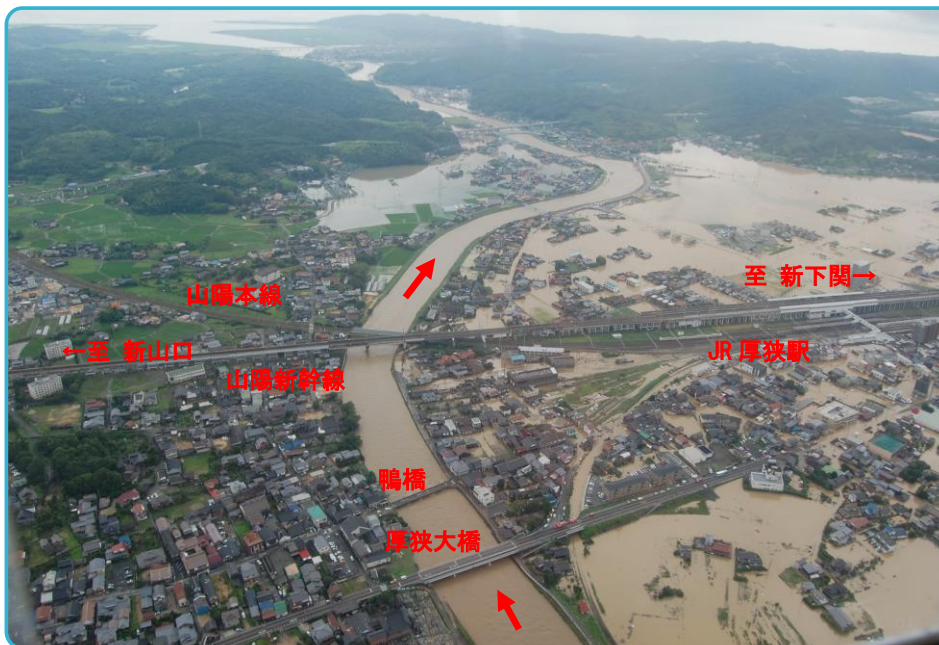
厚狭川周辺の氾濫状況（上空写真）
