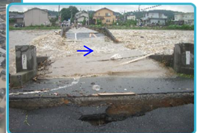
厚狭新橋が落橋
