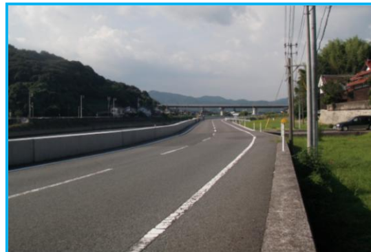
堤防嵩上げ完成後
