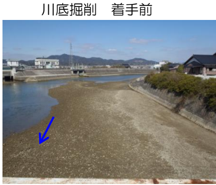
※水位が同じときの写真です。写真手前の川底の土砂を掘削しました。
