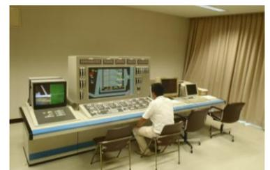
＜操作室＞ 雨の状況や川の水位など、操作室に集められた情報をもとに、水門、ポンプ、除塵機などの操作をしています。
