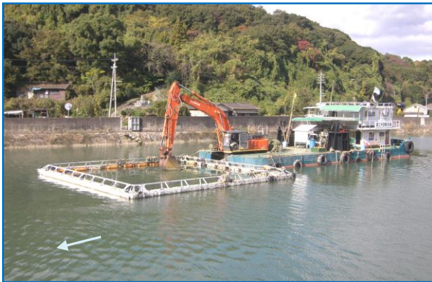
【厚狭川】下流部の川底の掘削工事
