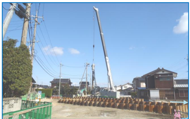
【桜川】山川橋の架替工事
