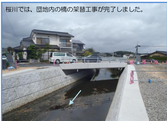
桜川（団地内）の橋の架替完了
