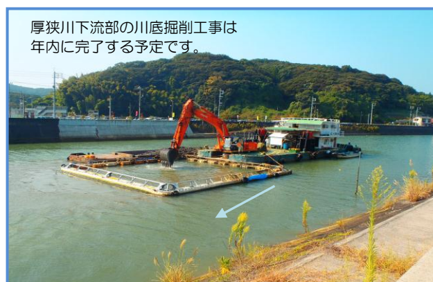
厚狭川下流の川底掘削工事の状況
