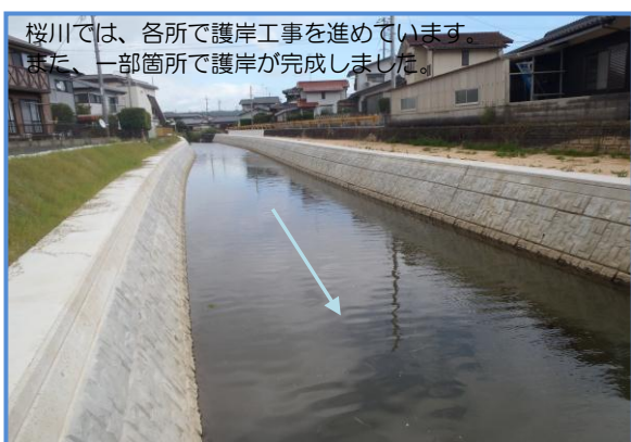
桜川の工事の状況
