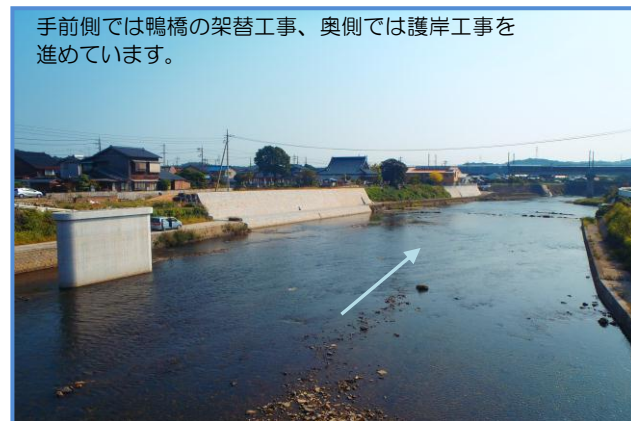
鴨橋周辺の工事の状況（鴨橋架替と護岸）
