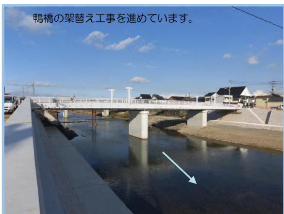
鴨橋の架替状況
