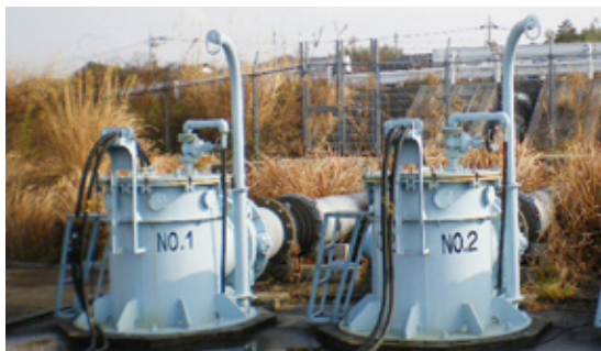
◀ 下木屋排水機場
