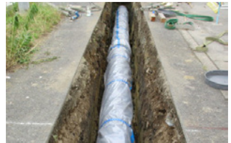
▲老朽化した水道管更新・耐震管布設工事
