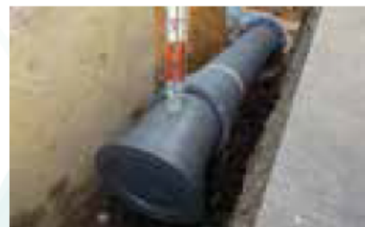
GX形ダクティル鑄鉄管
