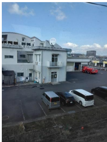
じじ 小野田線から見る小野田消防署
