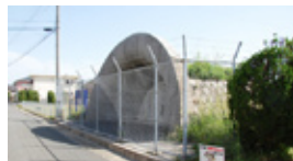
▲旧本山炭鉱斜坑坑口などを巡ります。
