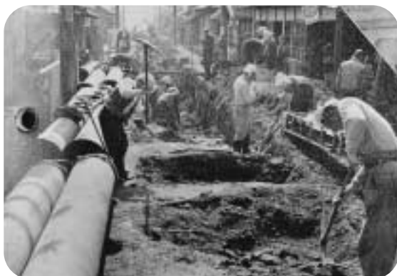
●昭和33年ごろの水道工事 (現在の赤崎二丁目)
