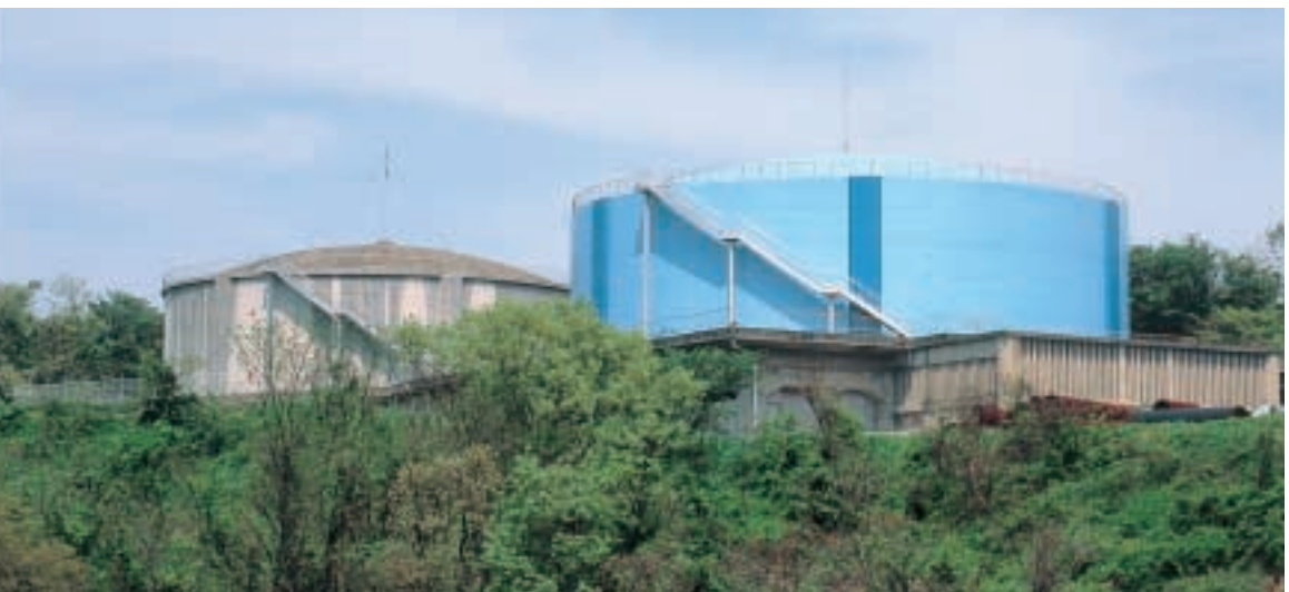
● 高尾配水池 お はい ち
