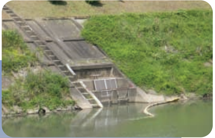
● あ さ か わ し ゅ す い く ち 厚狭川取水口
