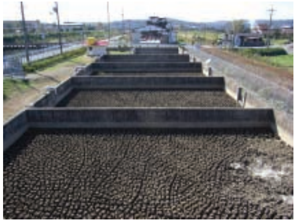
お でい かん そう ち ● 汚泥乾燥地
