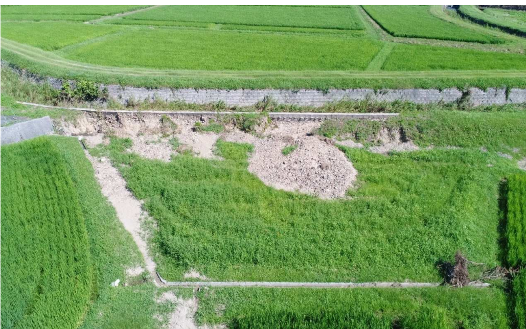
⑰ 13-105 農業用施設災害(道路) 七日町 (B箇所)
