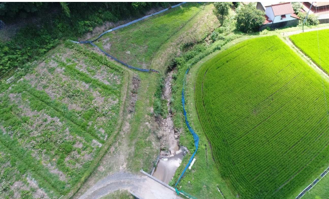
⑮ 13-107 農業用施設災害(水路) 福田9号 (B, C箇所)
