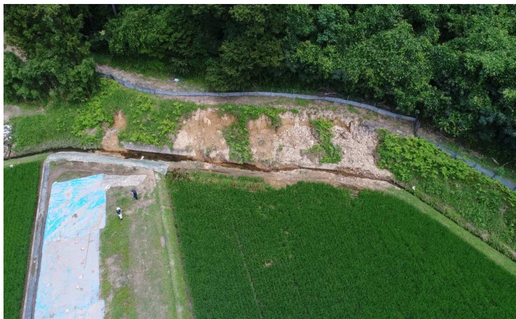
⑪ 13-101 農業用施設災害(水路) 柳瀬 (A、B、C箇所)
