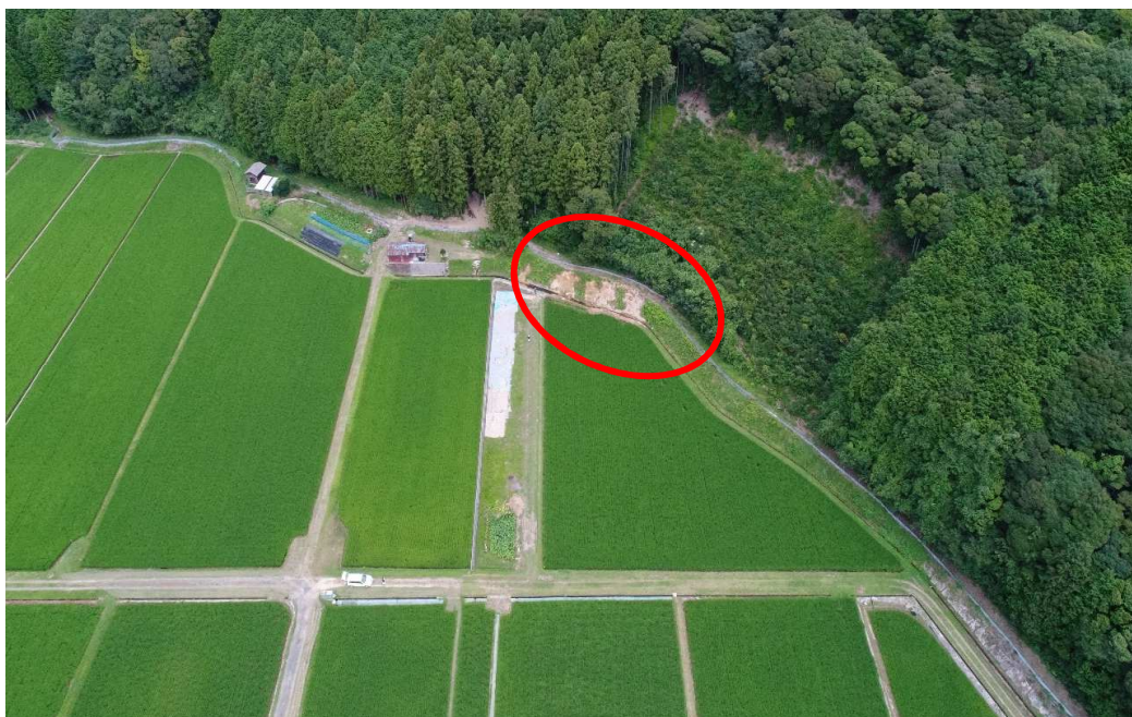
⑪ 13-101 農業用施設災害(水路) 柳瀬 (A、B、C箇所)
