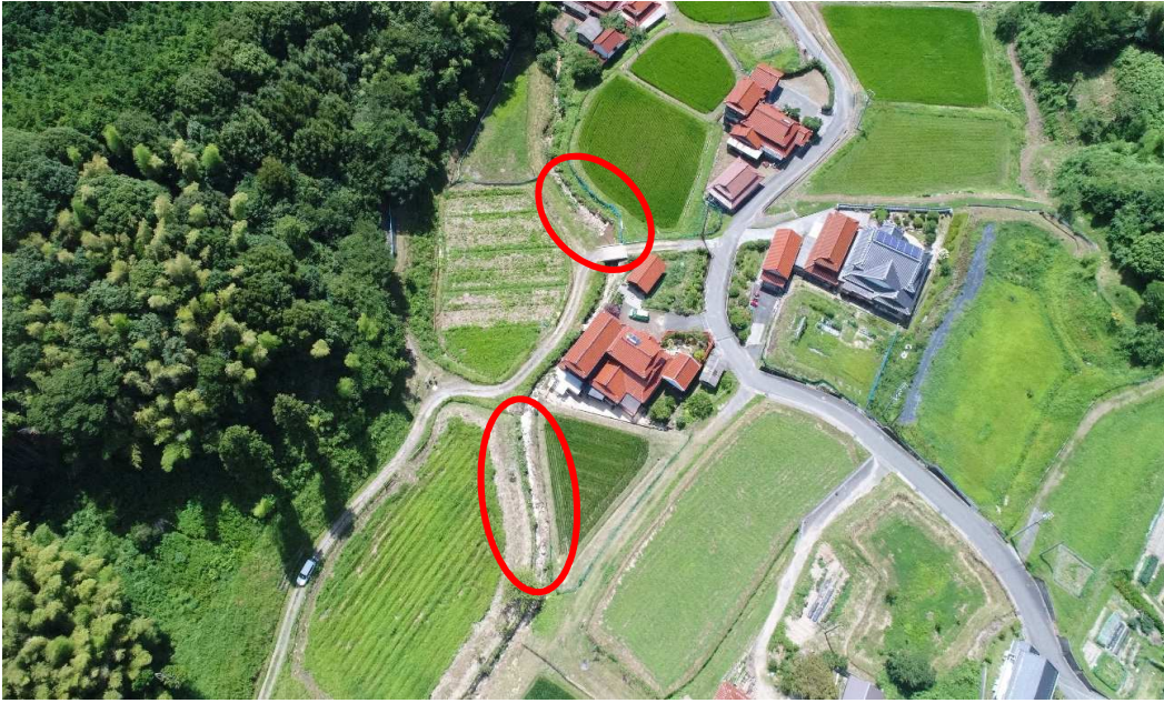
⑮ 13-107 農業用施設災害(水路) 福田9号
