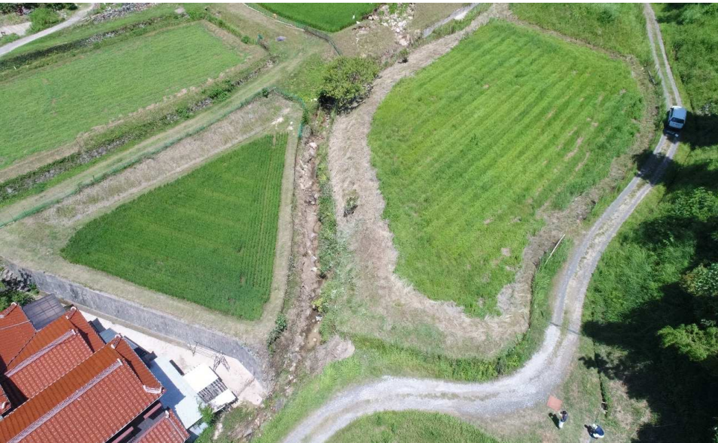
⑮ 13-107 農業用施設災害(水路) 福田9号 (A箇所)
