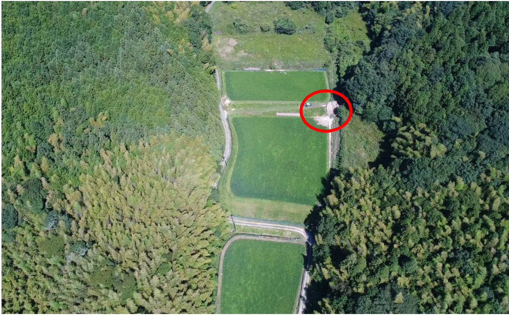
⑩ 13-104 農業用施設災害(道路) 福田5号
