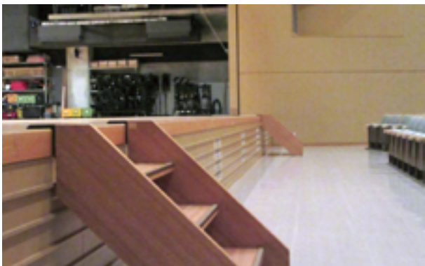
昇降段に手すりがない
