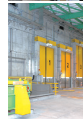
新ごみ処理施設 (平成 26 年度完成)
