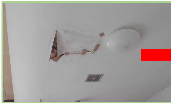
(修繕前の天井)
