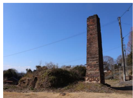
⑪ 旧河野製陶所跡 登り窯 煙突と上2段の袋
