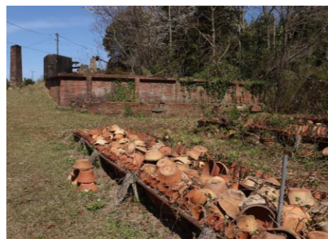
⑪ 旧河野製陶所跡 バック(沈殿濃縮施設)とオロ(乾燥施設)
