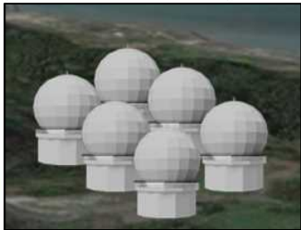
レーダー局舎
