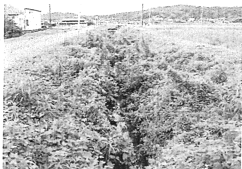
② 傾斜が厳しく足場がない
