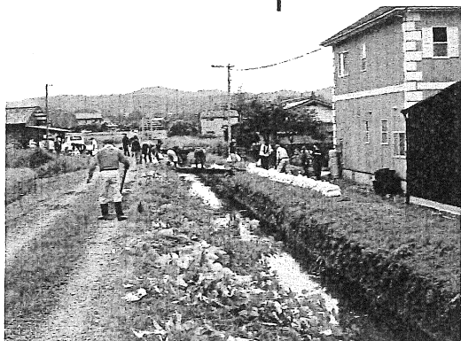
① 自治会員による土嚢積み
