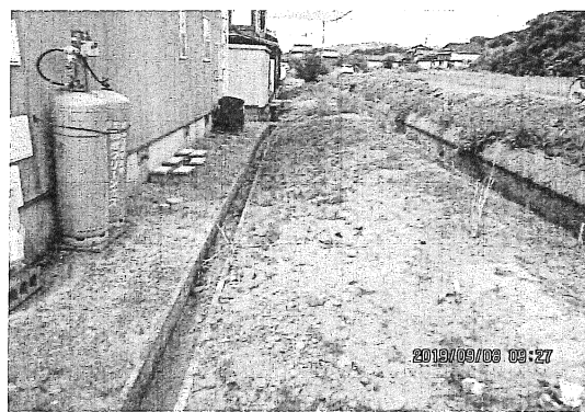
① 梅雨の大雨で浸水した箇所
