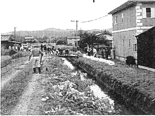
① 自治会員による土嚢積み
