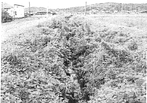
② 傾斜が厳しく足場がない
