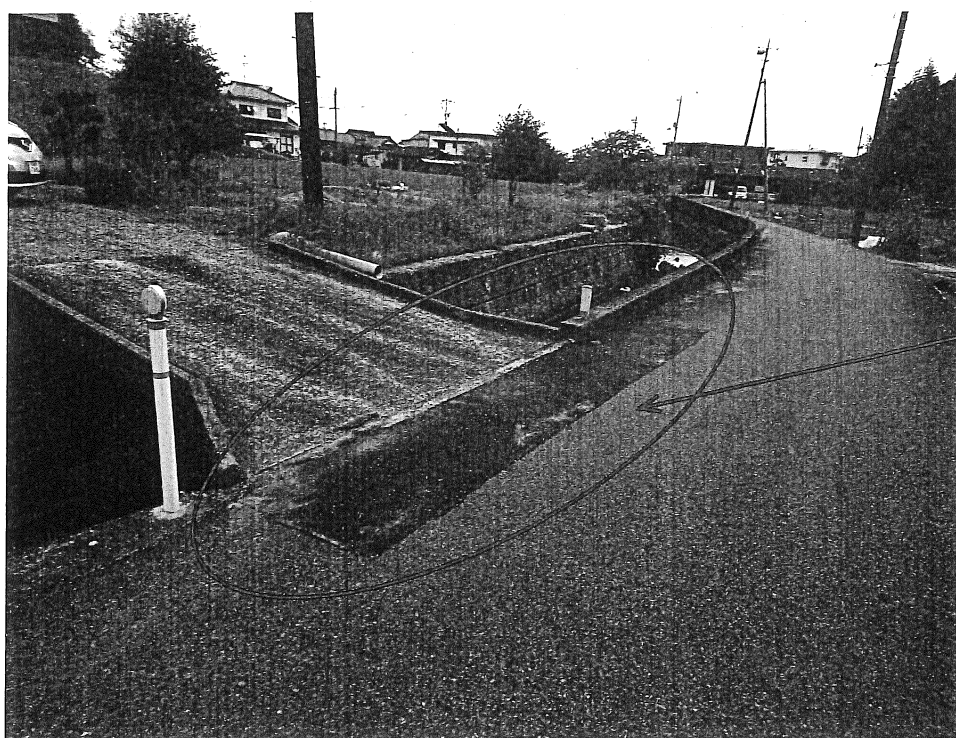
道路陥没補修跡(令和2年7月1日撮影)
