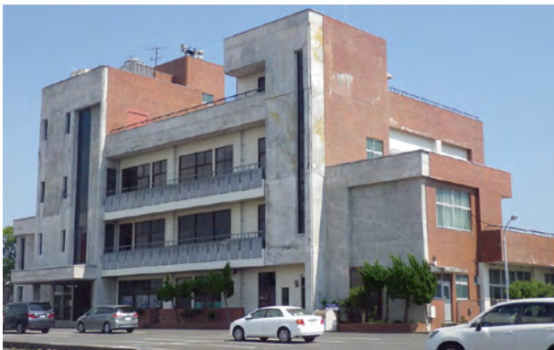
修理されないままの商工センター
