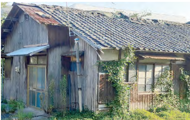
南中川公舎の現状
