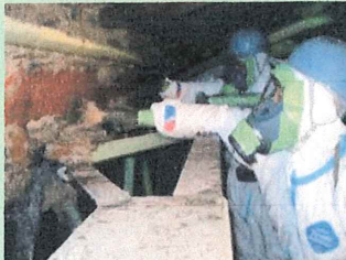
吹付け石綿の除去作業の様子
