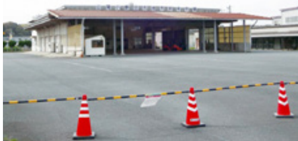
閉鎖された地方卸売市場
