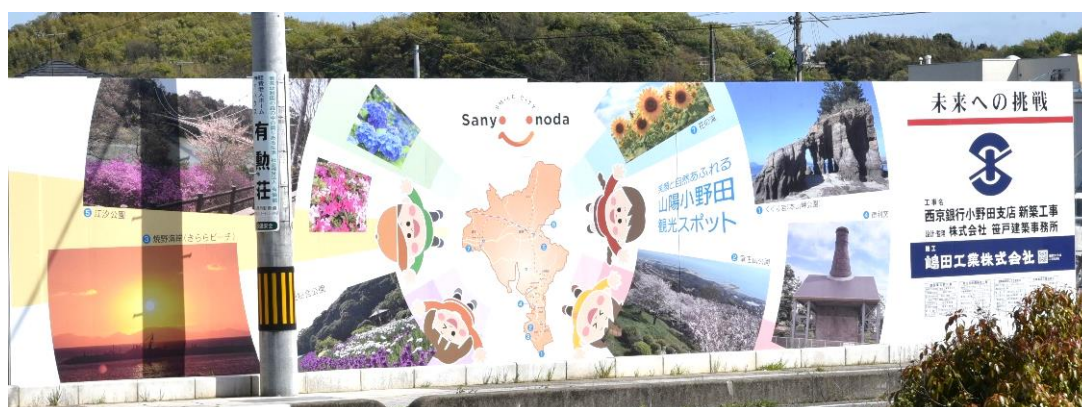
ロゴマークと市内の観光地をPRした工事現場の仮囲い
