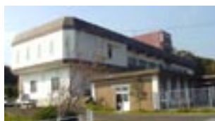
▲高天原浄水場
