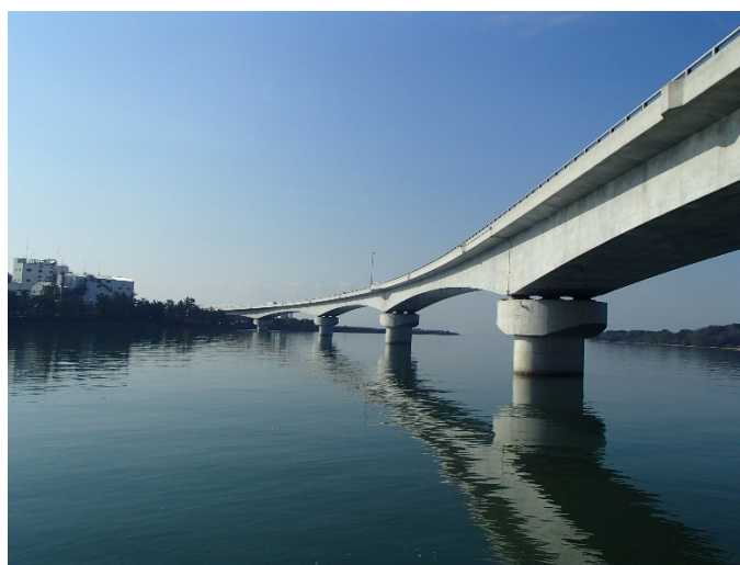
[小野田湾岸道路(有帆川大橋)]
